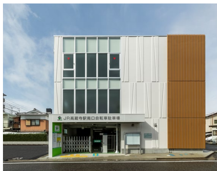
【外観(東面全景)】
