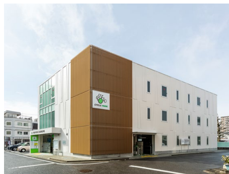
【外観(北東面全景)】
