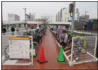
南流山駅前広場自転車駐車場 (新築)
