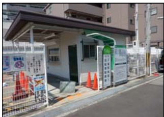
正雀駅南第1自転車駐車場 (大規模修繕)
