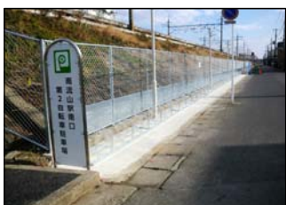
南流山駅南口第2自転車駐車場 (新築)
