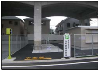
南多摩駅東自転車等駐車場 (新築)
