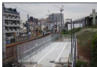
亀戸駅東口第2自転車駐車場 (新築)
