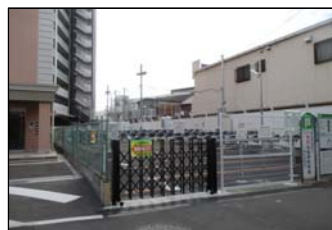
正雀駅南第3自転車駐車場 (大規模修繕)
