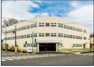
和光市駅北口立体自転車駐車場（新築）
