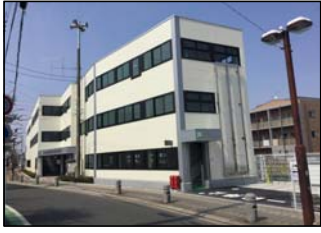
寒川駅南口自転車駐車場（新築）
