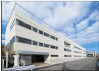
大船駅西口自転車駐車場（建替）
