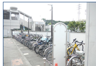
玉川上水駅第5公共自転車駐車場（新築）
