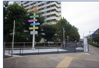
玉川上水駅第1公共自転車駐車場（新築）
