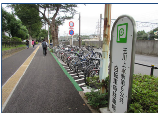
玉川上水駅第6公共自転車駐車場（新築）
