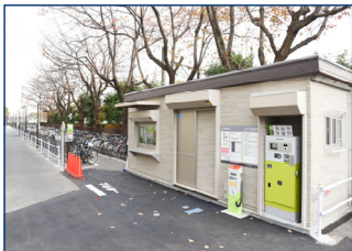
玉川上水駅第2公共自転車駐車場（新築）
