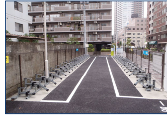
三鷹駅中町第3自転車等駐車場（新築）
