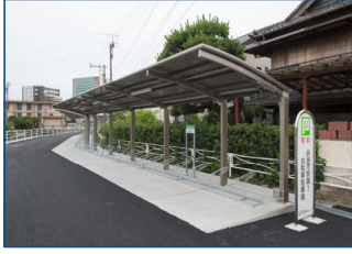
鈴鹿市駅第1自転車駐車場 (新築)
