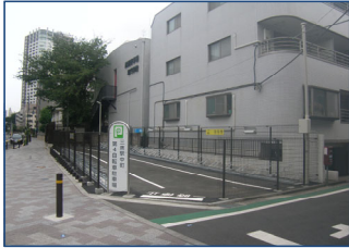
三鷹駅中町第4自転車等駐車場（新築）
