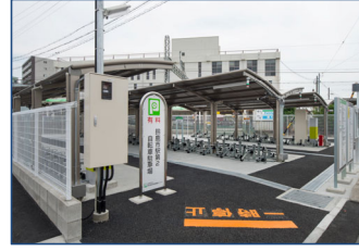
鈴鹿市駅第2自転車駐車場 (新築)
