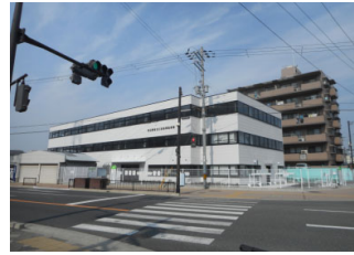
岸辺駅東北自転車駐車場 (改修)
