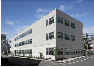
西八王子駅南臨時自転車駐車場 (建替)
