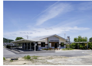
三雲駅前南口自転車駐車場 (新築)
