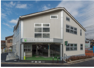
笠幡駅第一自転車駐車場 (建替)
