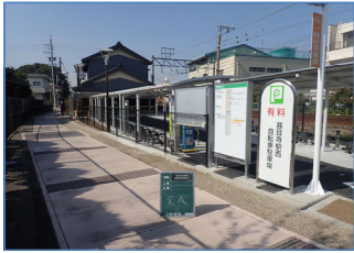
碓目寺駅西自転車駐車場（新築）
