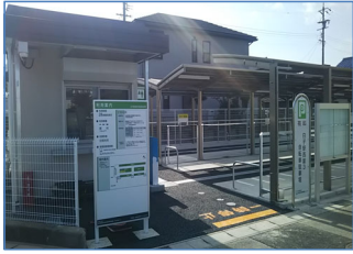
白子駅第3自転車駐車場 (新築)
