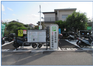
番田駅西口横自転車駐車場（新築）
