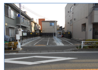
南流山駅南口第4自転車駐車場 (新築)
