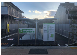
碓目寺駅南自転車駐車場（新築）
