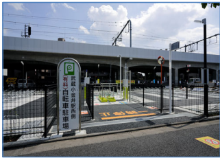
武蔵小金井駅西側自転車駐車場（新築）
