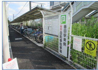
番田駅東口自転車駐車場（新築）
