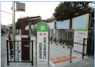
武庫之荘駅前南口自転車駐車場 (新築)
