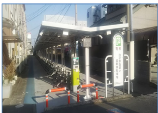
白子駅第2自転車駐車場（新築）
