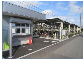
番田駅西口自転車駐車場（新築）
