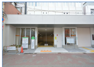
庄内駅前庁舎自転車駐車場 (新築)
