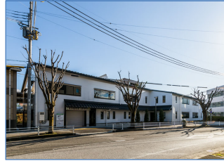
南彦根駅西第4自転車駐車場（新築）
