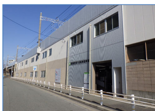
園田駅西第1自転車駐車場（大規模修繕）
