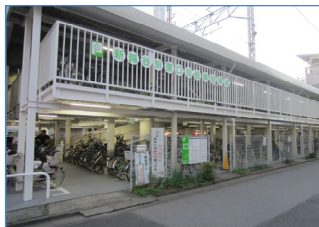
新越谷駅東口自転車駐車場（大規模修繕）
