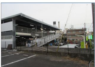
相武台前駅北自転車駐車場（大規模修繕）
