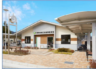
三雲駅前南口自転車駐車場（新築）
