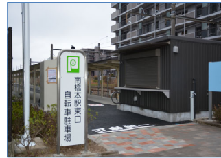
南橋本駅東口自転車駐車場（新築）
