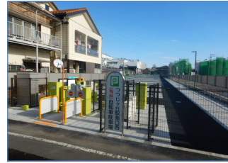
つつじヶ丘駅南口西自転車駐車場（新築）
