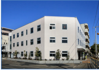
つじヶ丘駅南第1口自転車駐車場（新築）
