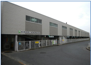
高尾駅南口自転車駐車場（大規模修繕）
