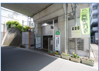
明石駅西第1自転車駐車場（大規模修繕）
