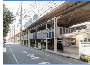
新越谷駅西口自転車駐車場（大規模修繕）
