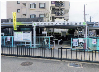
岸辺駅前第2自転車駐車場（大規模修繕）
