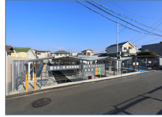
吉見ノ里駅自転車駐車場（新築）
