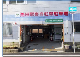
池田駅東自転車駐車場 (大規模修繕)
