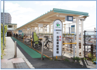
朝霧駅第3自転車駐車場 (大規模修繕)
