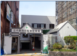
庄内駅西自転車駐車場 (大規模修繕)
