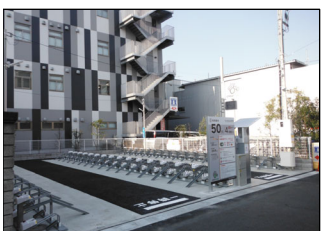
西八王子駅北口第4自転車駐車場（新設）
