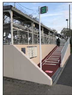
相原駅西口自転車駐車場（大規模修繕）
