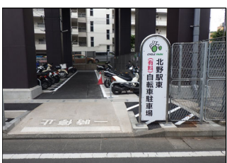
北野駅東自転車駐車場（増設）
