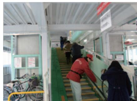
上層への移動がしやすいベルトコンベア
