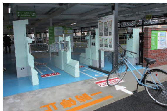
下：CYPS ゲート導入例 (常滑駅東駐輪場(愛知県常滑市))
