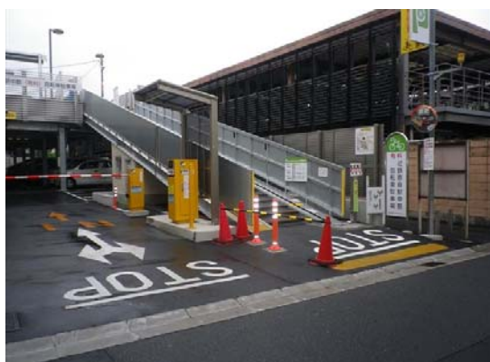
▼1階：自動車駐車場、2階：自転車駐車場
