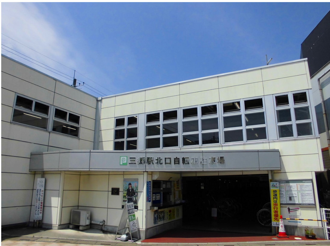
▼三郷駅北口自転車駐車場の外観
