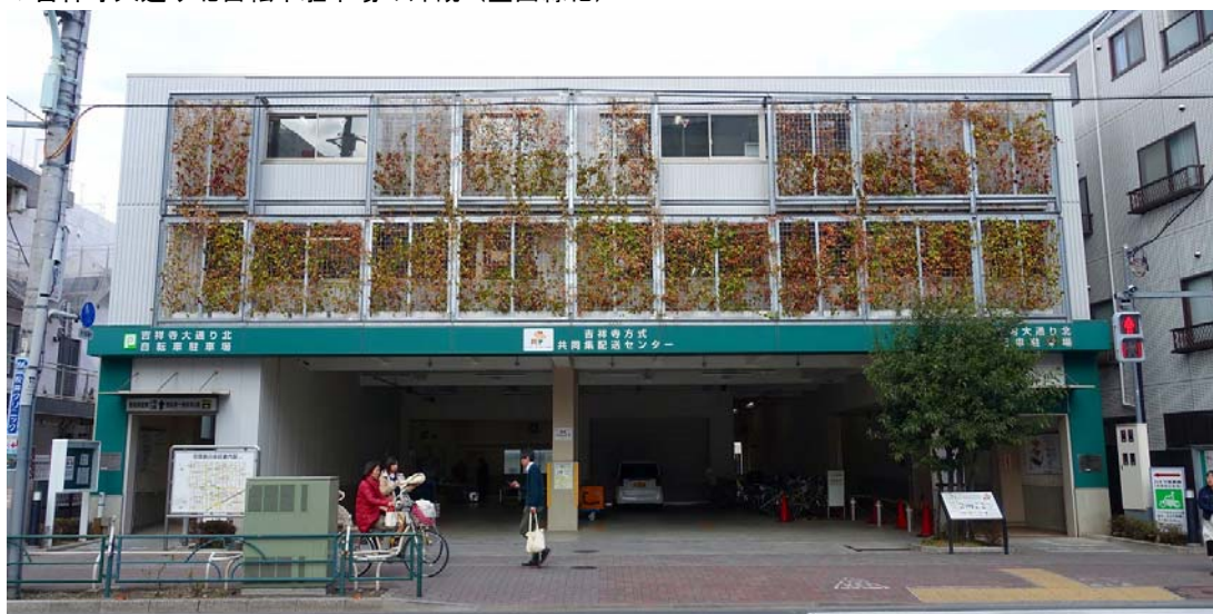
▼吉祥寺大通り北自転車駐車場の出入口
