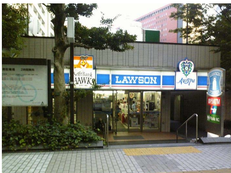
▼1階：コンビニエンスストア、2階：自転車駐車場
