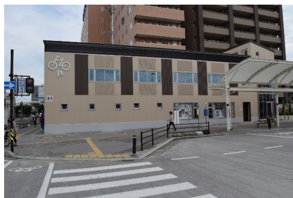
津波時避難施設（鈴鹿市近鉄白子駅駐輪場）
